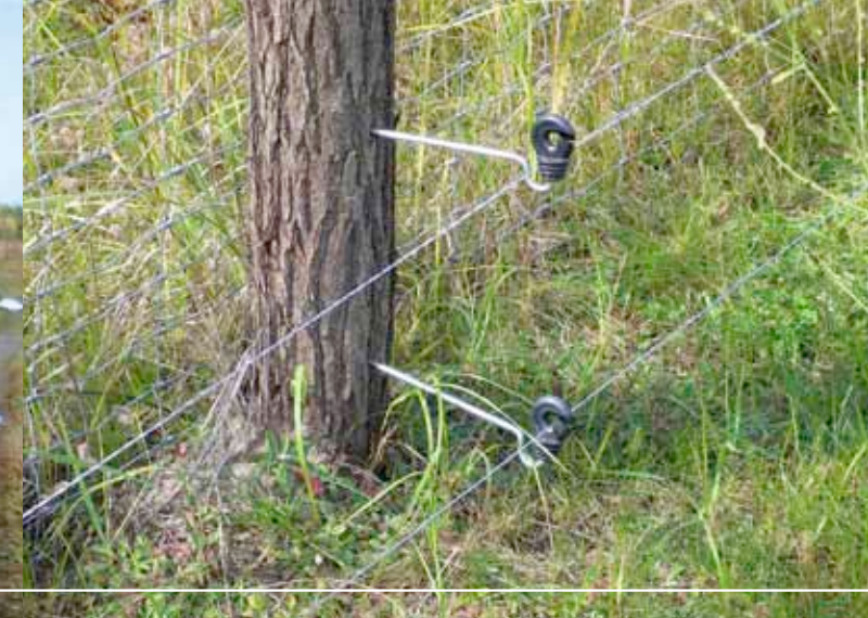
Maßnahme 4: Unterwühlenschutz bei Wildgattern
